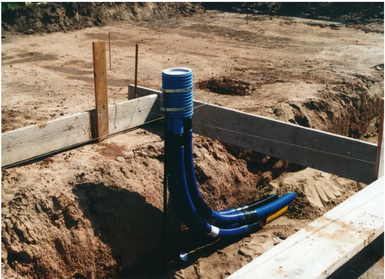
Mehrspartenhausanschluss am Schnurgerüst ausgerichtet
